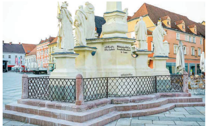
Die Pestsäule hat nun wieder eine Einfriedung, es handelt sich um die sanierten originalen Gitter-Elemente. Foto: Russold
