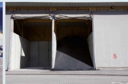
Trockene Lagerung von Schüttgütern / Dry storage of bulky goods
